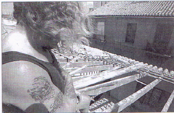
Derribo de la antigua fábrica de la calle Llíria de Valencia.
