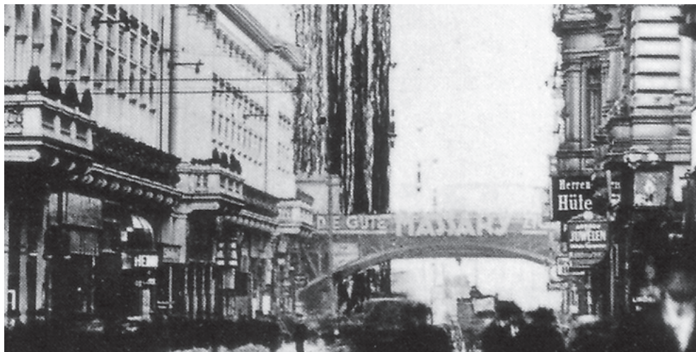
Ampliación, y encuadre parcial del "fotomontaje del Media Campus Axel Springer, Berlín (2014), arquitecto: Rem Koolhaas", el cual incluye de manera recortada el "fotomontaje del rascacielos de vidrio para Friedrichstrasse, Berlín (1921), arquitecto: Mies van der Rohe"
