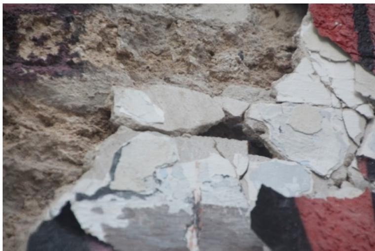
Fig. 15 Fotografía detalle de la descohesión de estratos
