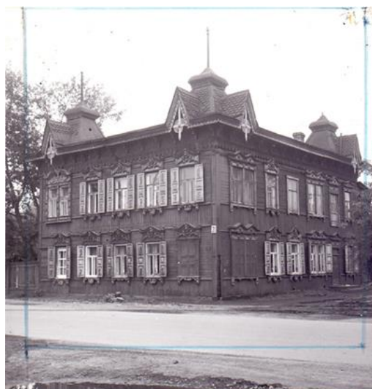
Fig. 10. Francisco Cabrero. Fotografía de vivienda de madera en la periferia de Irkutsk, Rusia, 1976. AGUN.
